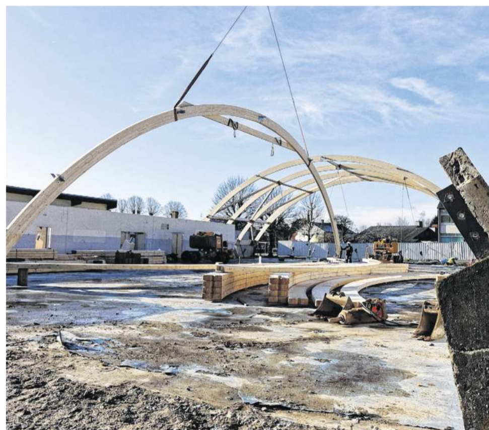
Chaque arche a dû rejoindre son support existant (à droite). Le Bulletin
