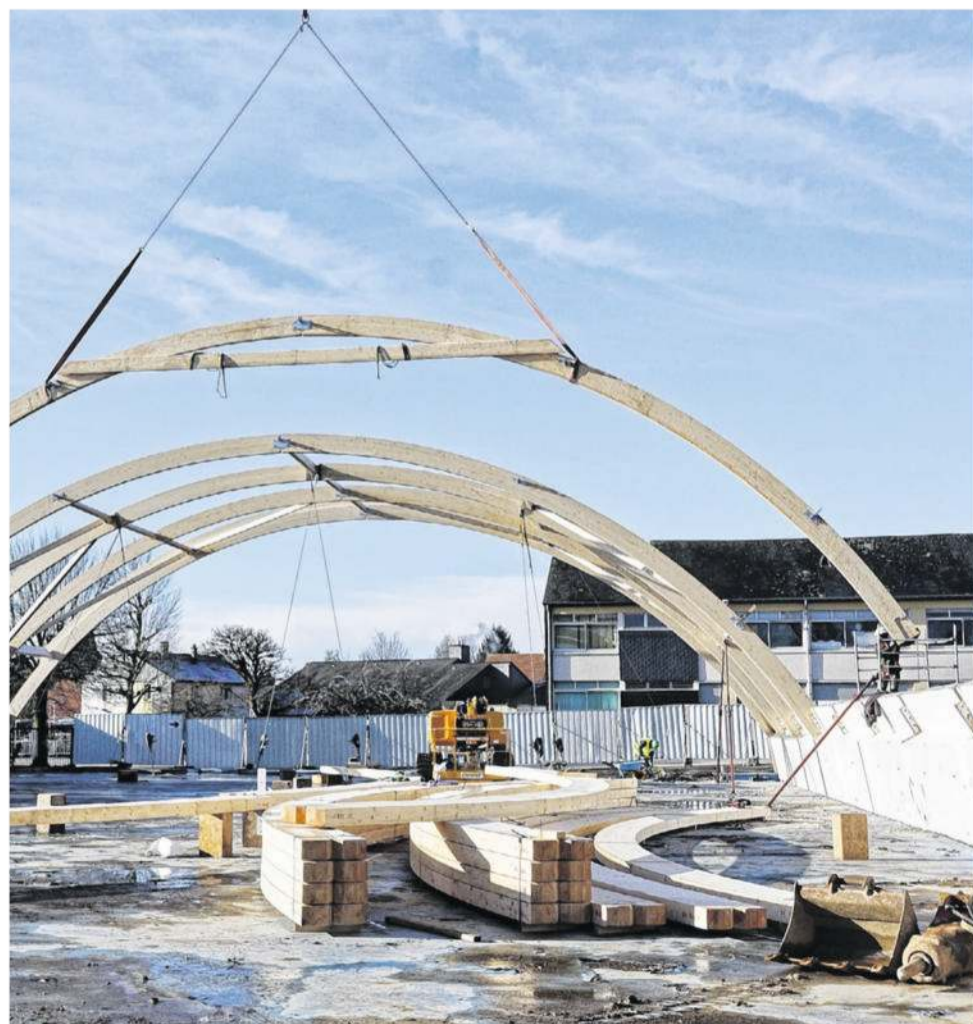
Les compagnons charpentiers ont posé chaque arche sur les murs d'origine. Le Bulletin
