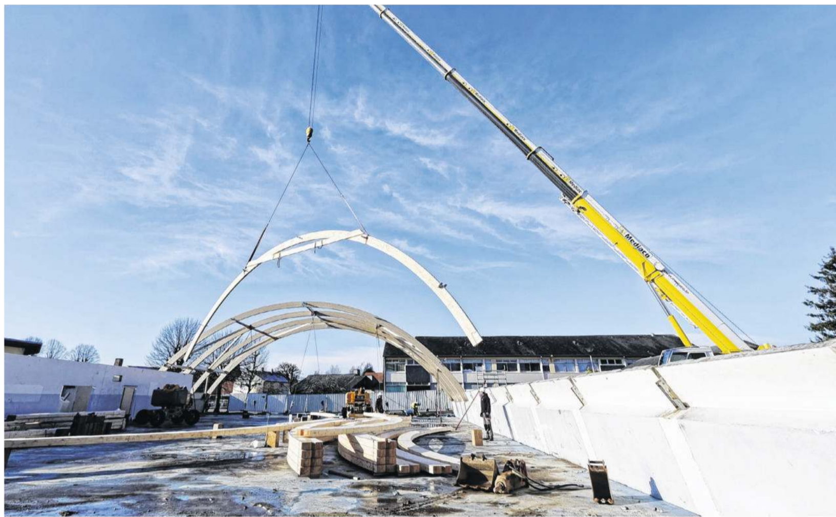
La difficulté fut de garder les structures d'aplomb. Le Bulletin
